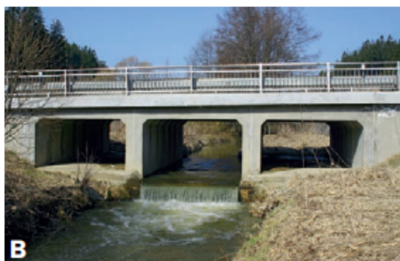
Obr. 9 Vhodná řešení. Příklady mostů, u kterých existují v podmostí suché břehy a jsou tudíž pro vydru průchozí. Zdroj: Hlaváč et al. 2017.
