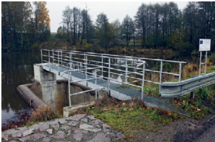
Obr. 16 Nevhodné řešení. Tzv. sdružený bezpečnostní objekt vytváří ve většině případů pro vydru nepřekonatelnou bariéru. Zdroj: Hlaváč et al. 2017.
