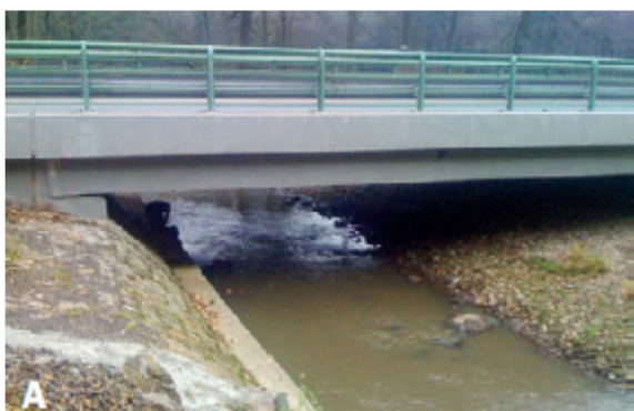
Obr. 9 Vhodná řešení. Příklady mostů, u kterých existují v podmostí suché břehy a jsou tudíž pro vydru průchozí. Zdroj: Hlaváč et al. 2017.
