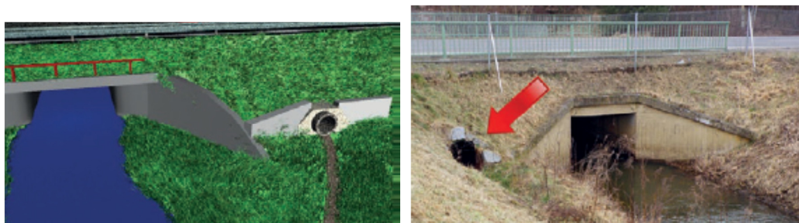
Obr. 11 Úpravy nevhodných mostů – vydří tunel. Pokud není možné vybudování berm či lávek (nepřípustné snížení kapacity mostu, příliš složité či nákladné řešení), je možné most zprůchodnit vybudováním vydřího tunelu. Zdroj: Hlaváč et al. 2017.
