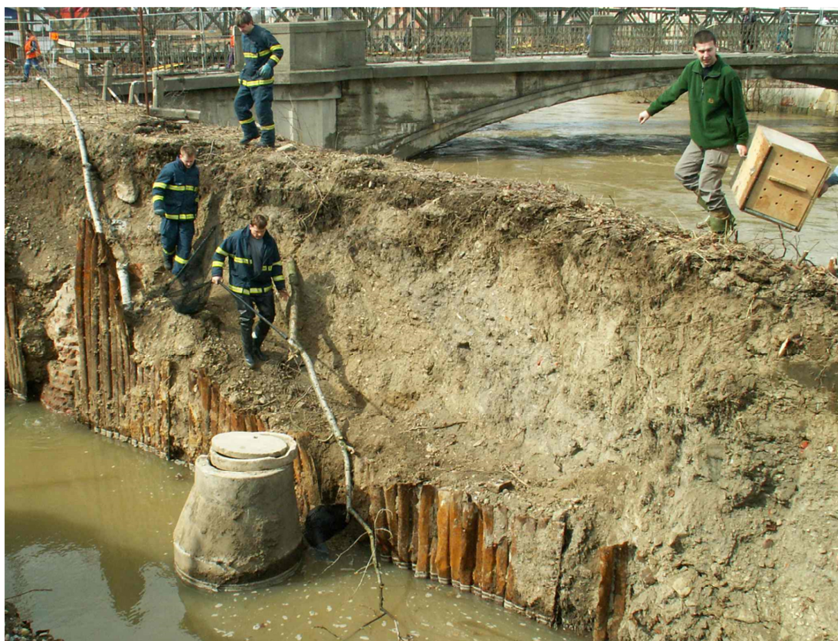
Obr. 13: Odchyt bobra, zapadlého do výkopu v centru Olomouce v roce 2006
