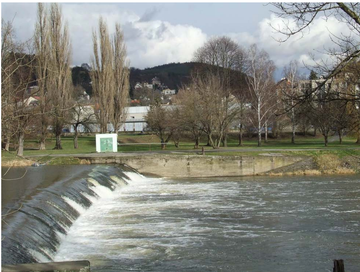
Obr. 2 Pohled na jez z pravého břehu řeky (stav před zahájením stavby)
