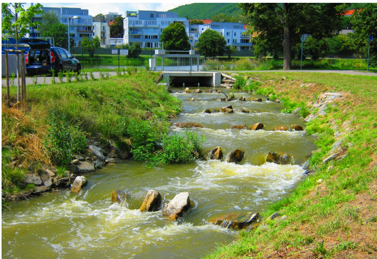
Obr. 4 Dokončený rybí přechod (červenec 2012)
