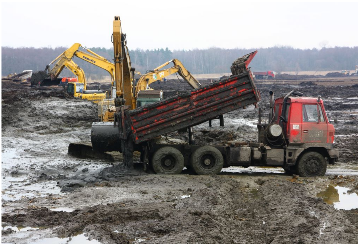
Transport řídkého sedimentu ze dna na mezideponii Foto: Vlastimil Peřina
