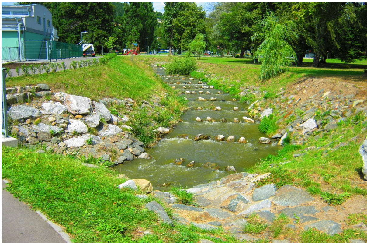
Obr. 3 Dokončený rybí přechod (červenec 2012)
